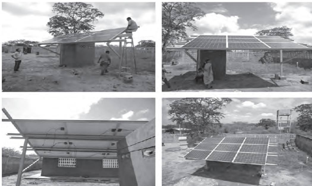
Figura 3. Instalación del sistema fotovoltaico en la comunidad Indígena Etkojo >ole.
